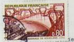
Barrage de VOUGLANS (Jura)
