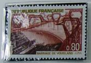
Barrage de Vouglans (Jura)
